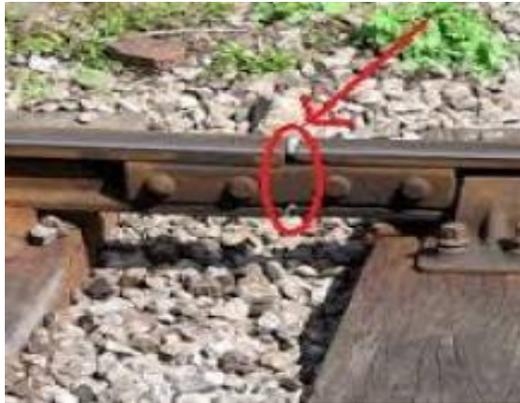
Gambar diatas menunjukkan gambar sambungan antar rel kereta api yang dibuat agak renggang untuk memberi ruang saat rel mengalami pemuaiian.
