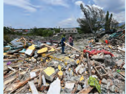
Kerusakan akibat gempa Sumber: liputan6.com
